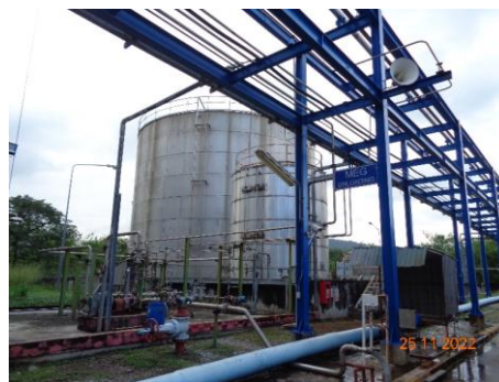
ภาพที่ 2.2-33 คันกั้นล้อมรอบ MEG Tank
