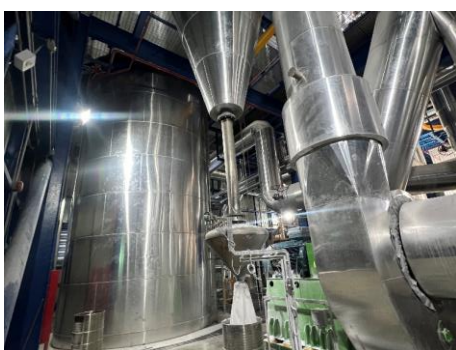
ภาพที่ 2.2-3 ระบบ Cyclone บริเวณหน่วยผลิต เม็ดพลาสติกพีดี (SSP)
