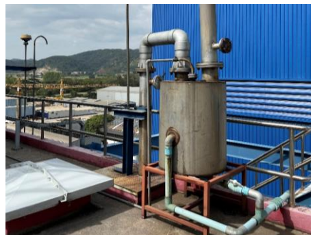
ภาพที่ 2.2-2 ระบบ Scrubber บริเวณปล่อง Catalyst Feed Vessel
